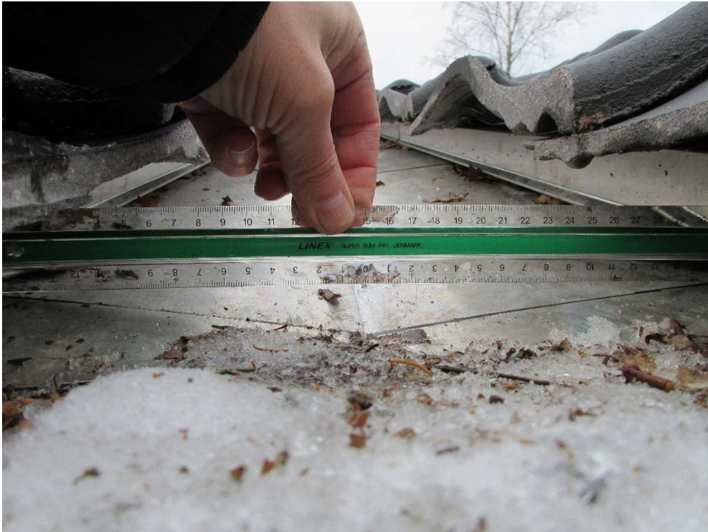
Foto 2: Kontrol af skotrendehøjde. Målt bredde på 160 mm og målt højde på 23 mm
